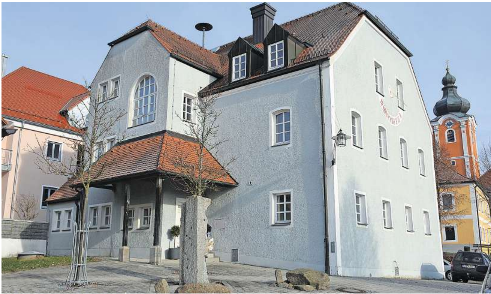
Geplant waren bei der Anmeldung zum Kommunalen Investitionsprogramm (KIP) sowohl die Barrierefreimachung als auch die Energetische Sanierung des Dieterskirchener Rathauses. Geblieben ist jetzt die Verstärkung der Innendämmung, neue Fenster und der Brandschutz im Treppenhaus. Foto: R. Gohlke
