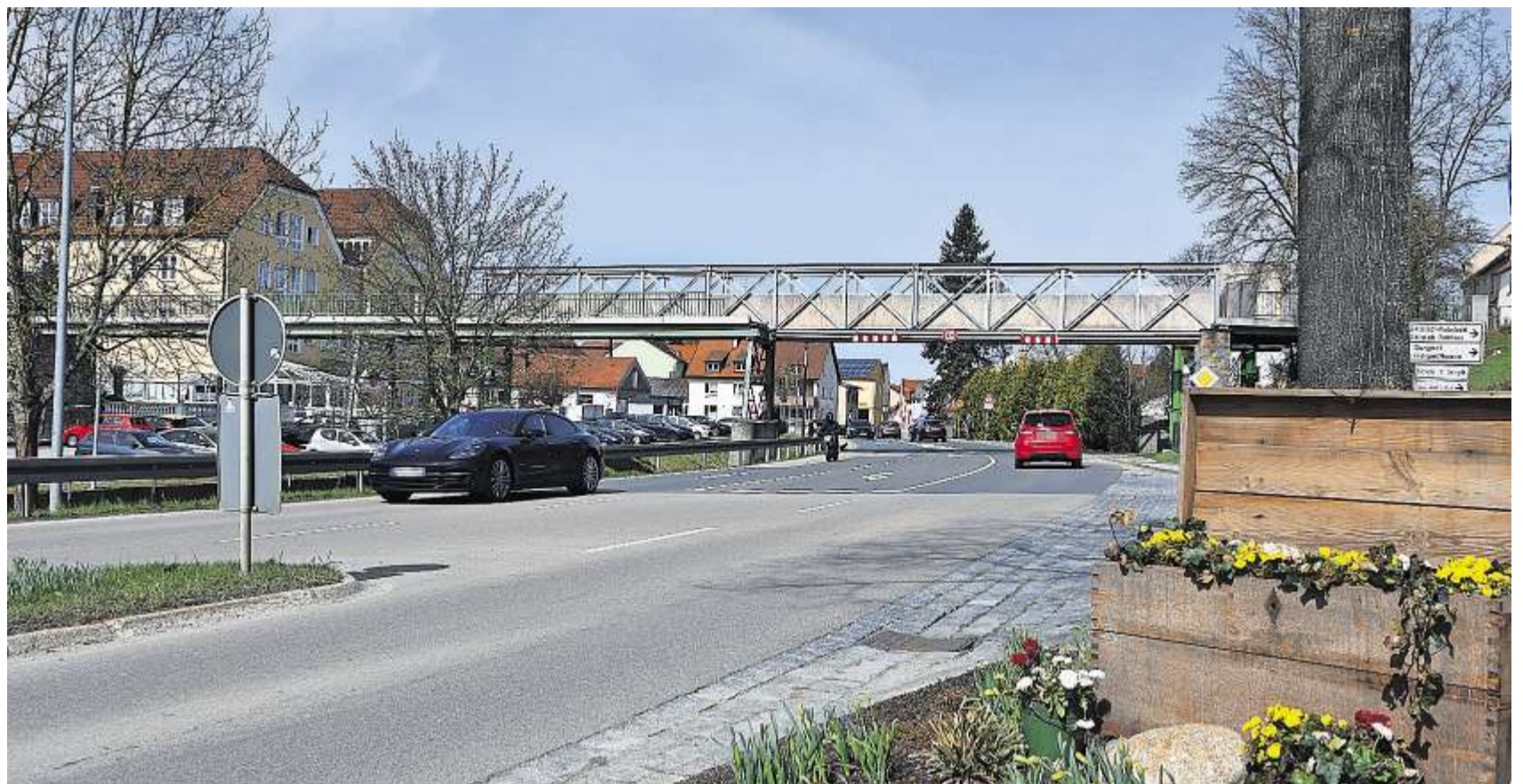
Derzeit gelangen Radfahrer und Fußgänger über eine Behelfsbrücke über die vielbefahrene Konrad-Adenauer-Straße in Neunburg. Jetzt gibt es Hoffnung, einen Neubau des Eisernen Stegs realisieren zu können.
